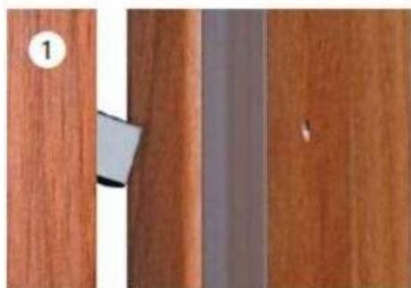
Après avoir installé la serrure et avoir sorti le crochet, l'axe du percement sera marqué en fermant la porte sur le montant de réception.
